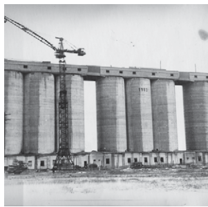
Завершение строительства цементных силосов
