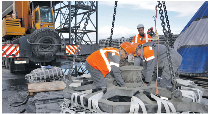
Обучение стропальщиков натяживанию горловины МК контейнеров на траверсу
