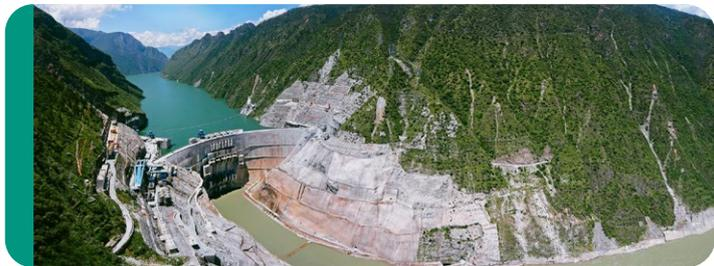
Объект представляет собой бетонную каскадную плотину с управляемым водохранилищем в нижнем течении реки Ялонг. Проект арочного сооружения с двойным изгибом воплотил в себе современные достижения технологий строительства. Для его реализации пришлось переселить 7500 местных жителей в другие регионы. Плотину возводили в течение девяти лет, после запуска в 2014 году она была внесена в книгу рекордов Гиннеса по высоте.
