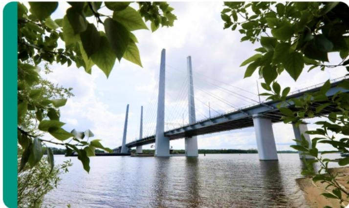
При возведении моста было уложено 45000 кубических метров бетона, 8800 тонн металлоконструкций, более 2000 тонн асфальта. Длина вантового перехода составила 220 метров, а конструкция всего моста – 1132 метра. Протяженность подходов к мосту достигла 8 километров, ширина каждой из шести автомобильных полос получилась 4,5 метра.
