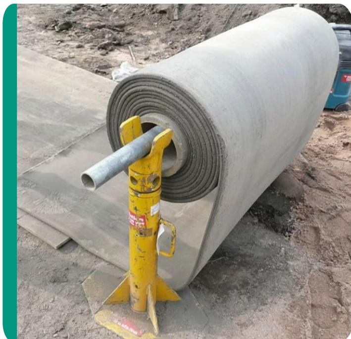
Участки стыков пропитывают водой, затем производят водную обработку всей бетонной ткани. Повторно увлажняют рулонный бетон через час. Для придания полной герметичности можно применить технологию термосварки или нанести на швы клей-герметик.
