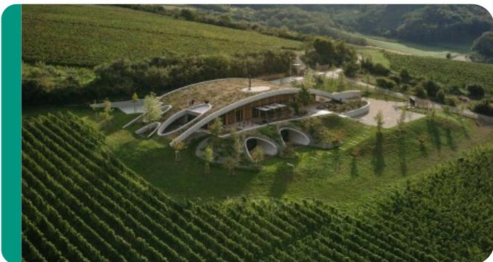
Архитекторы отметили, что одной из самых сложных задач при строительстве стало сооружение пятидесятиметровой арочной крыши и эллиптической конструкции из железобетона. После строительства на ее поверхности высадили травы, кустарники и деревья, характерные для этой местности. Таким образом, удалось создать эффект зеленого холма, выросшего среди виноградников.
