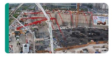
В 2015 году самая большая непрерывная заливка товарного бетона была выполнена в России при строительстве самого высокого здания нашей страны «Лахта Центр» в Санкт-Петербурге. Заливка производилась в непростых погодных условиях с 27 февраля по 1 марта, точная продолжительность составила 49 часов. Бетон поставляли с 13 бетонно-растворных узлов, общий объем смеси достиг 19 624 м³. В результате заливка была внесена в книгу рекордов Гиннеса.
