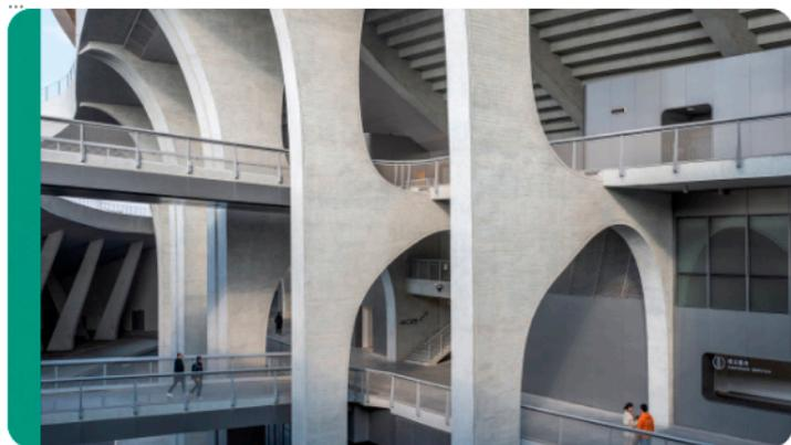
Открытый бетон имеет необычную фактуру благодаря отпечаткам деревянной опалубки. В конструкции комплекса предусмотрены округлые прорезы, обеспечивающие доступ солнечного света во внутренние зоны и паркинг. Внутренняя отделка выполнена с применением древесно-бетонных плит.
