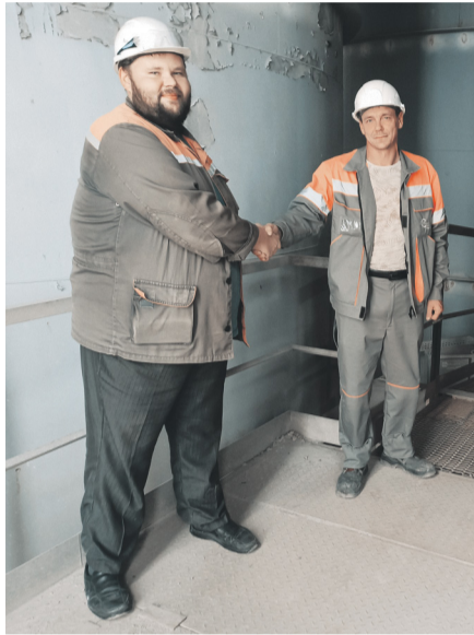
Артем Ливерко (слева) благодарит старшего мастера ремонтного управления Алексея Голуба за монтаж площадки обслуживания системы газового анализа
