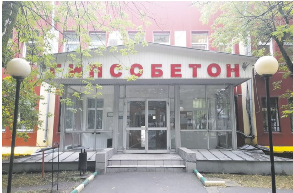
Историческое здание заводоуправления
